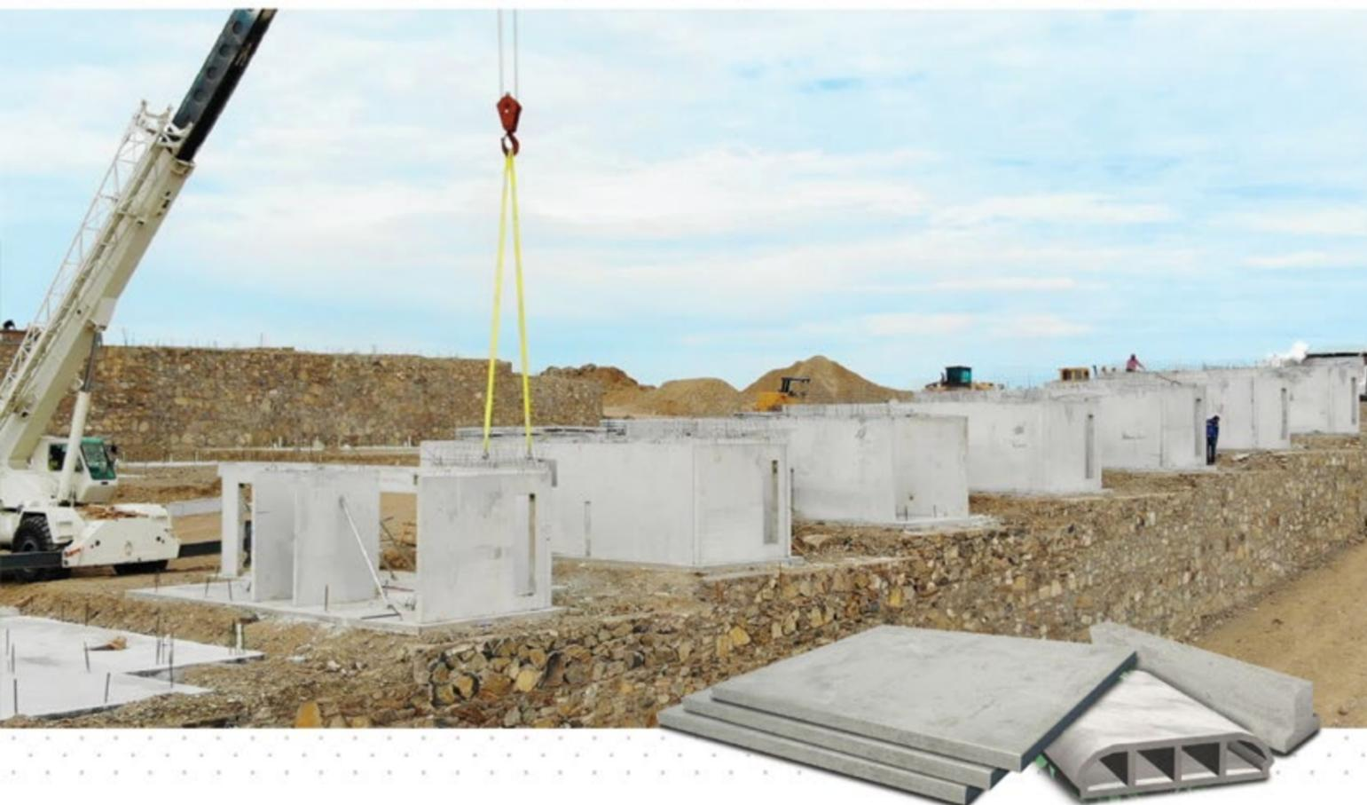
Casas térmicas prefabricadas como sistema modular, compuesto por paneles térmicos en muros de losa de vigueta – bovedilla con placa aislante. Los beneficios de utilizarlo son contar espacios abiertos, estéticos y eficientes.
