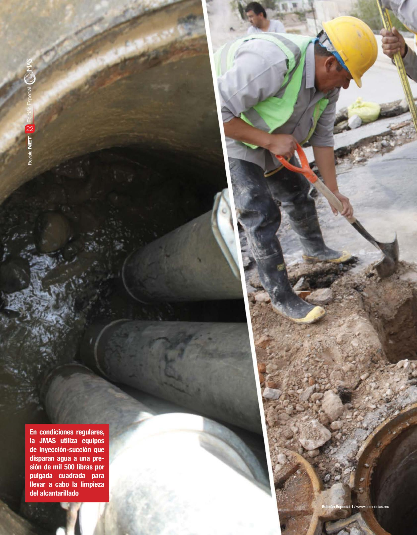
En condiciones regulares, la JMAS utiliza equipos de inyección-succión que disparan agua a una presión de mil 500 libras por pulgada cuadrada para llevar a cabo la limpieza del alcantarillado
