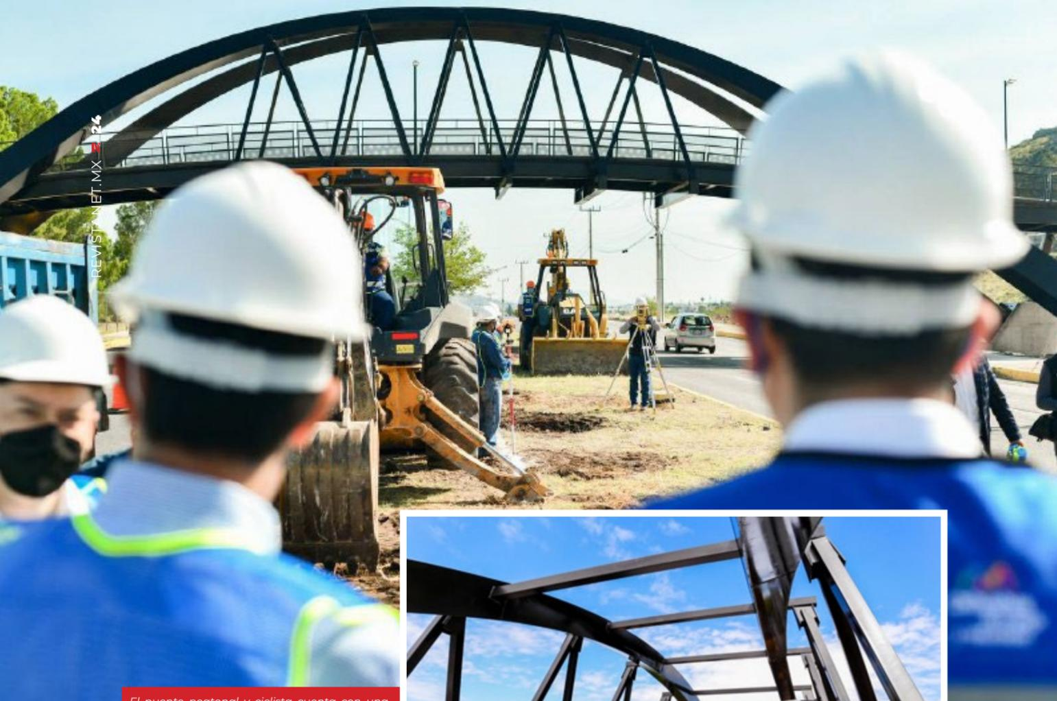
El puente peatonal y ciclista cuenta con una longitud de 124 metros y 5 metros de ancho, a base de metal y concreto hidráulico, rampas de acceso con muros, un barandal de acero, sendas peatonales y ciclistas
